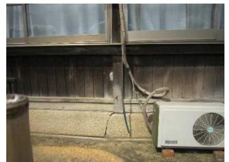
芸予地震で破損したと推定される布石の割れ
