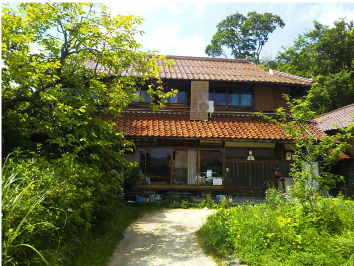
築110年の古民家の2階を改装したカフェ
